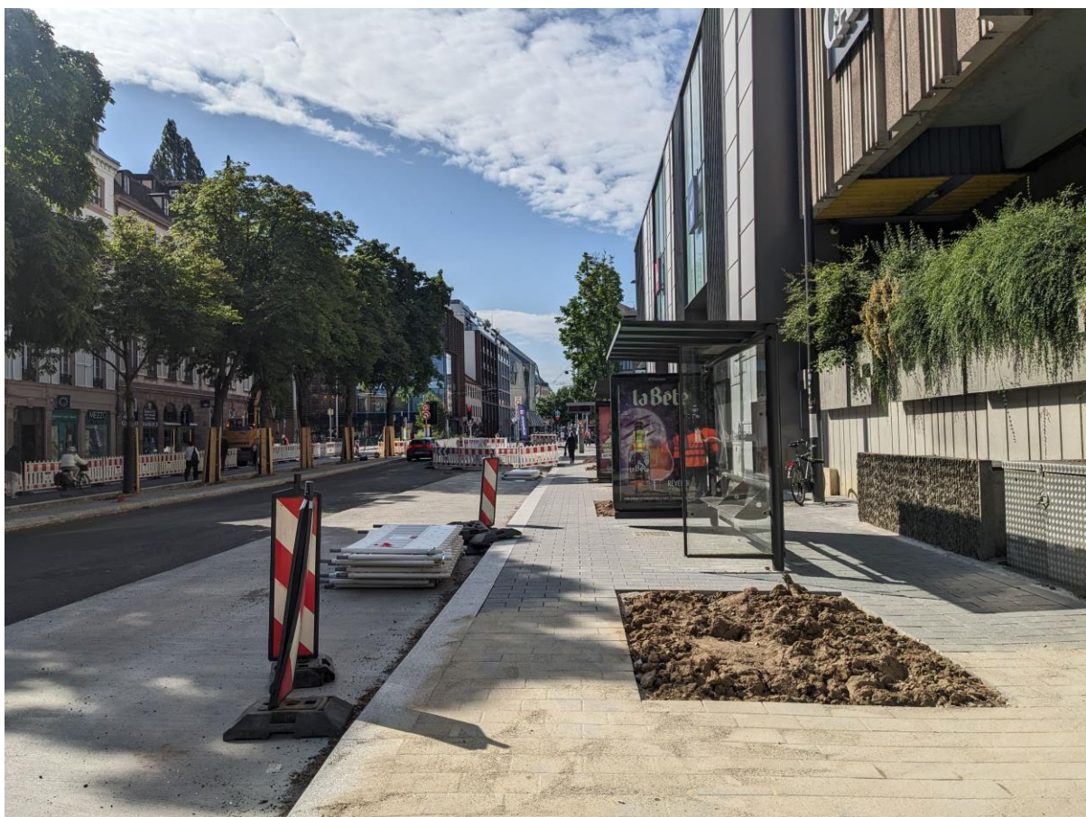
Aménagement du nouveau terminus "Les Halles Sébastopol" - mise en service à compter du 16 juin 2025.
